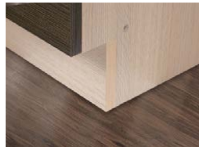
Podcinane boki szafek dolnych dla zachowania jednej linii cokołu.
